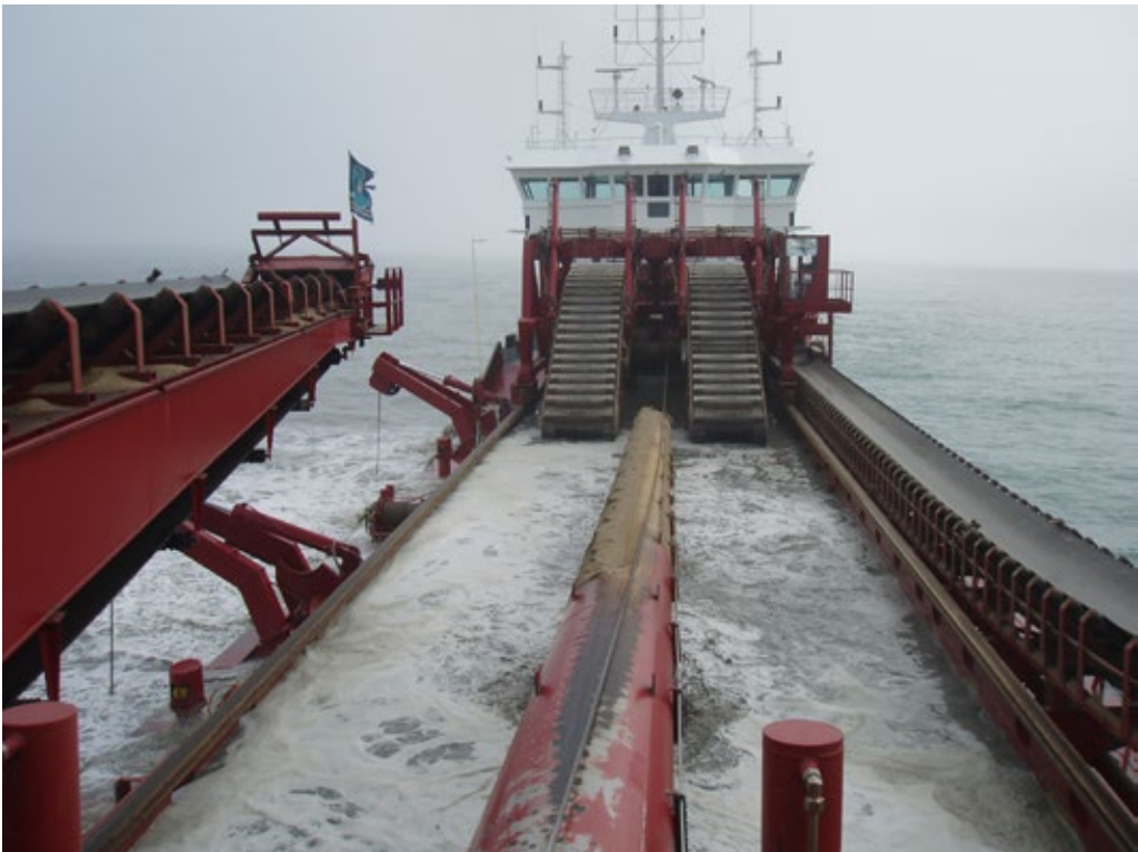
Baggerwerkzaamheden op de Noordzee
